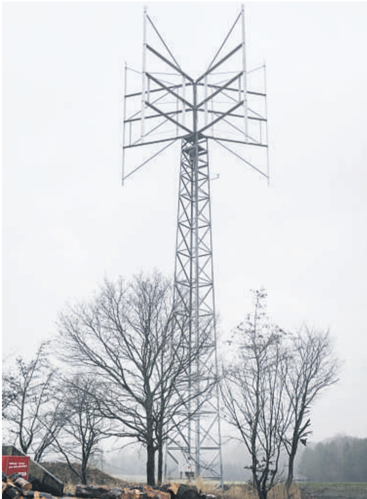
Der Rotor mit fünf Flügelementen hat eine Höhe von sechs Metern, die Gesamthöhe liegt bei knapp 30 Metern. FOTO: MICHAEL MAY
